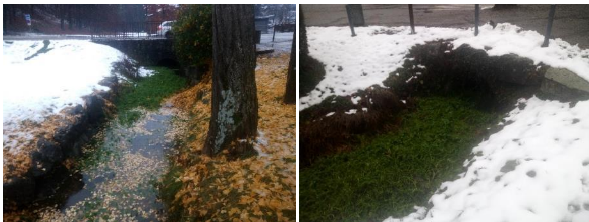
Fig. 4-k : Point de rejet de eaux pluviales arrivant au rond-point par temps de pluie. Aval à gauche, amont à droite.
