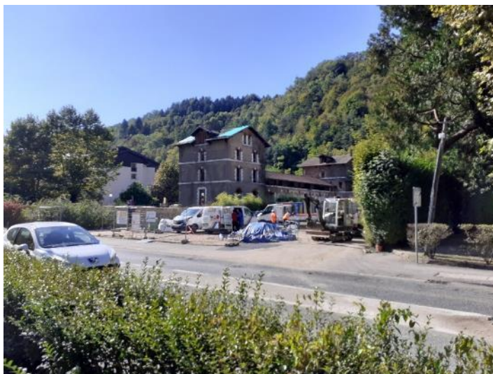
Fig. 4-i : Site de construction de l'immeuble
