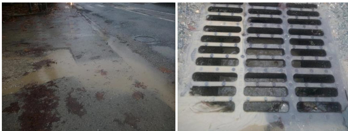
Fig. 4-l : Réseau d'eau pluvial aux abords du site en construction, par temps de pluie.
