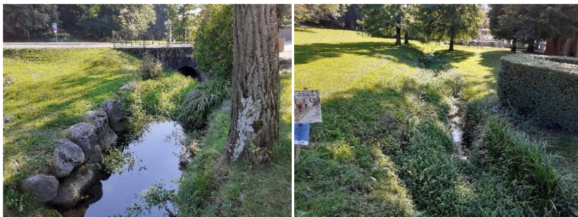
Fig. 4-j : Point de rejet des eaux pluviales arrivant au rond-point. Aval à gauche et amont à droite.
