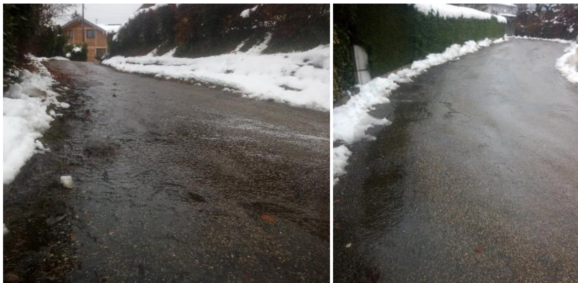
Fig. 4-d : Impasse du Luiset par temps pluie, le 01/12/21, vues orientées vers l'amont de l'impasse.
