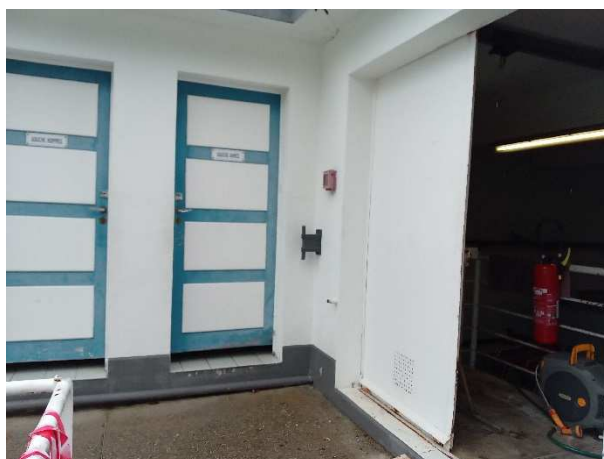
Local technique au sous-sol
